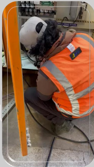
Instalación de tablero y armado eléctrico
