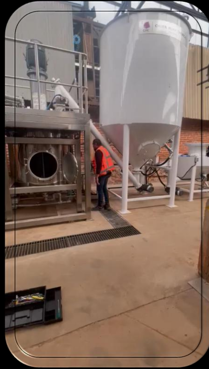
Instalación de maquinaria
