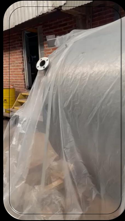
Instalación de maquinaria
