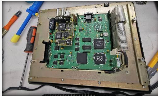
REPARACION PANEL HMI
