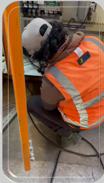
Instalación de tablero y armado eléctrico
