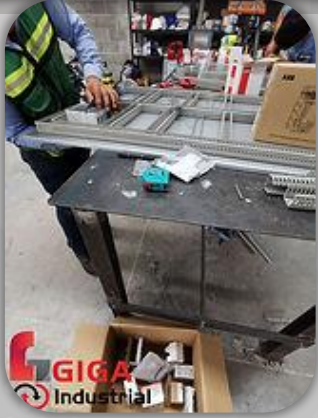
Diseño y Armado de tableros Eléctricos
