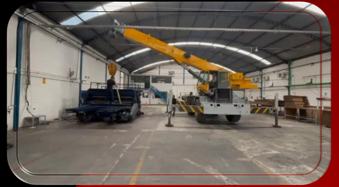
Departamento de electromecánica Instalación, puesta de servicios y puesta en marcha de Maquinaria
