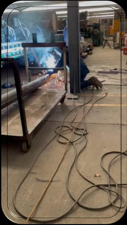
trabajos de pailería e instalación de Maquinaria
