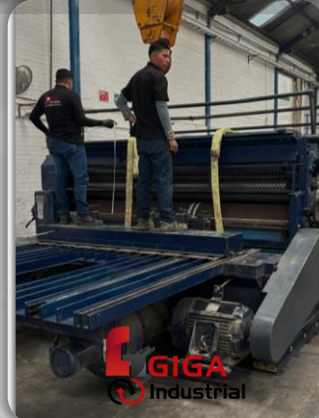
Instalación y Puesta en Marcha de Maquinaria Industria de Cartón
